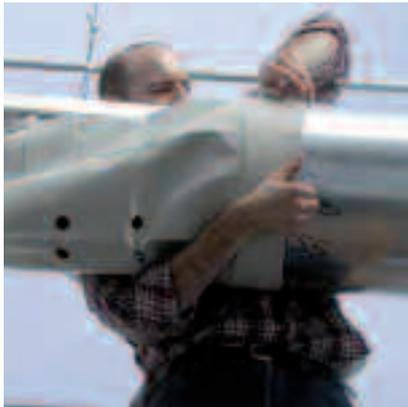
L'installazione dei Diffusori **AIR MIXING®** consiste nel posizionamento in quota del cavo di corredo, sul quale viene successivamente agganciata la tubazione **AIR MIXING®** con le apposite clips ad S per poi tesarla e raccorderla con i canali di collegamento alle unità di trattamento aria.
